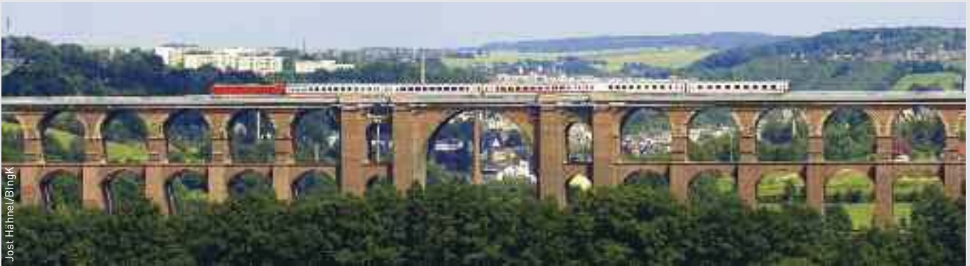
DAS GRÖSSTE ZIEGELBAUWERK der Welt ist eine ingenieurtechnische Meisterleistung: die Göltzschtalbrücke im sächsischen Vogtland.
