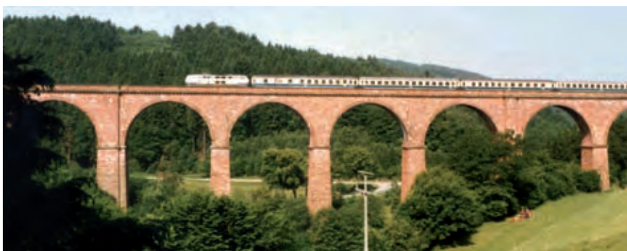
DAS HIMBÄCHEL-VIADUKT ist das sechste Wahrzeichen der Ingenieurbaukunst in Deutschland: die erste und höchste eingeschossige Eisenbahnbrücke Deutschlands
